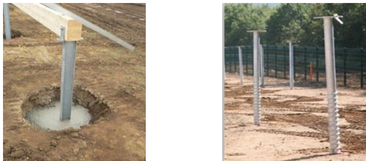
Photographie 4 : Fondation béton (à gauche) ; fondation vis (à droite) Source : EDF Renouvelables
