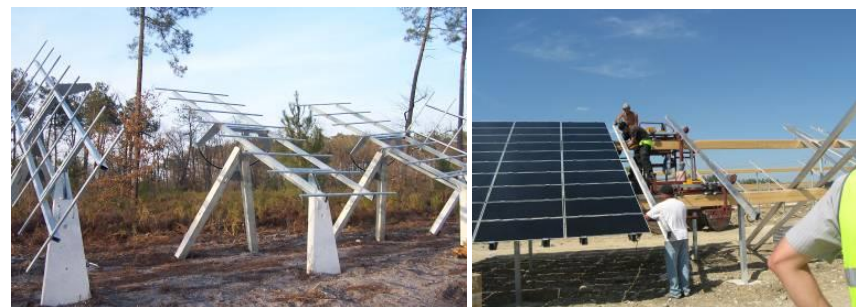
Photographie 5 : Montage des supports de la technologie « trackers » (à gauche), montage de modules sur des supports fixes (à droite) Source : EDF Renouvelables
