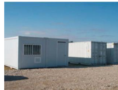
Photographie 2 : Installation de la base-vie Source : EDF Renouvelables
